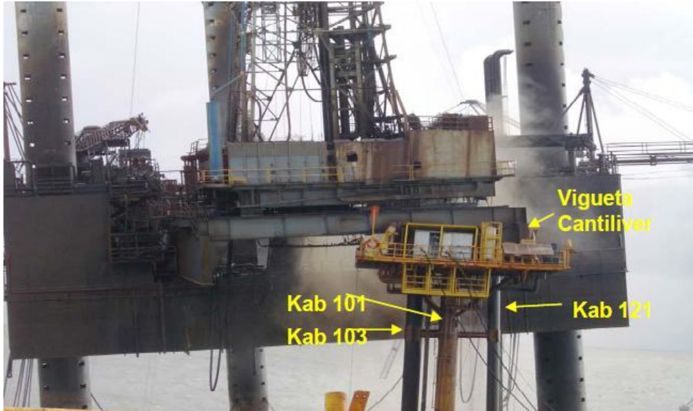
Figura I-4. Vista frontal de la Plataforma Usumacinta, exponiendo los pozos Kab-101, Kab – 121 y Kab – 103 (PEMEX, 2007).
