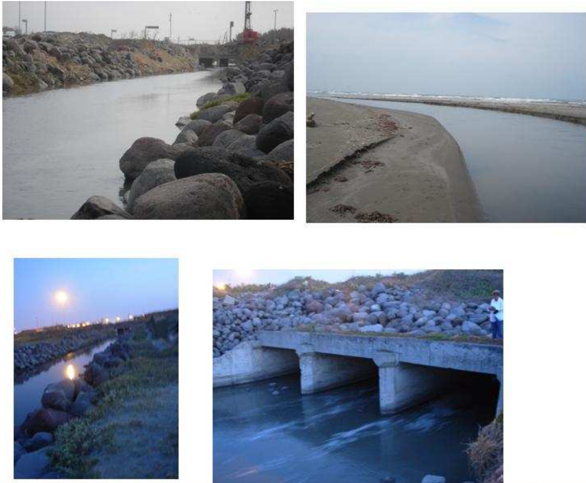
Figura 1.5: Arroyo El Cable. Descarga ubicada en 19^{\circ}12'51'' N, 96^{\circ}09'37'' W. En este sitio se unen las descargas tratadas y no tratadas, con un gasto total aprox. de 1700 l/s. La mayor parte de las aguas residuales de la ciudad descargan en este sitio [21].
